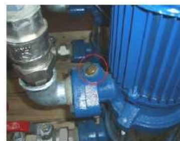
Obr. 6: montáž čidla na odvzdušňovací otvor výtlaku čerpadla
